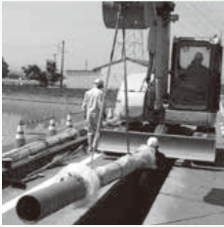
耐震管への取り替え工事
